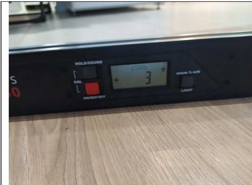
Фото №10. Измерения уровня напольного покрытия в кухне (ламинат).
