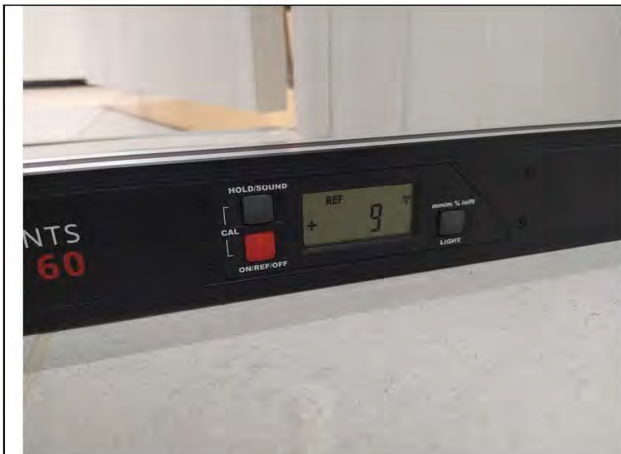
Фото №13. Измерения уровня напольного покрытия в ванной комнате (керамическая плитка).
