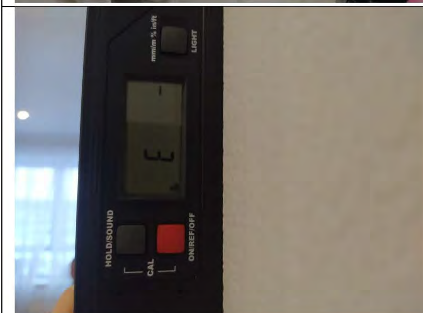
Фото №5. Измерения уровня стен в кухне.
