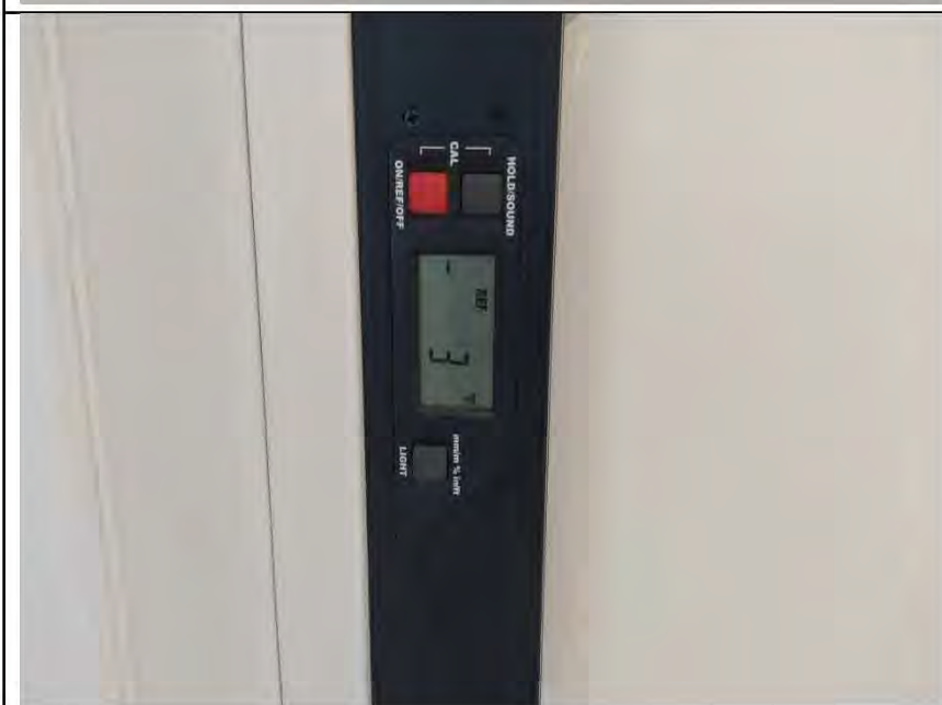
Фото №45. Отклонение коробки входного дверного блока
